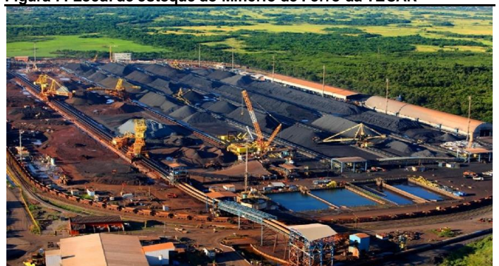
Figura 7: Local de estoque do Minério de Ferro da TECAR
