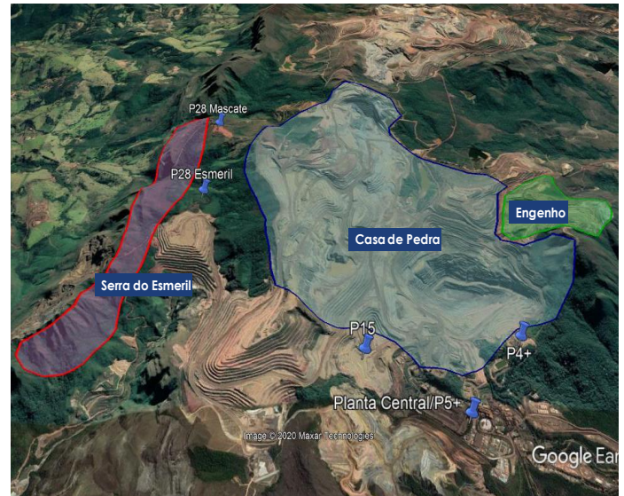
Figura 2: Imagens de satélite das minas Casa de Pedra e Engenho
